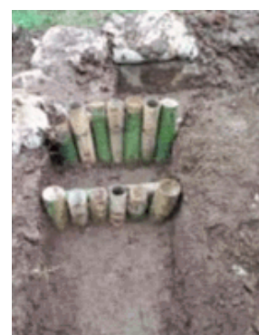
Gambar 4. Perangkap Sedimen dari Bambu
